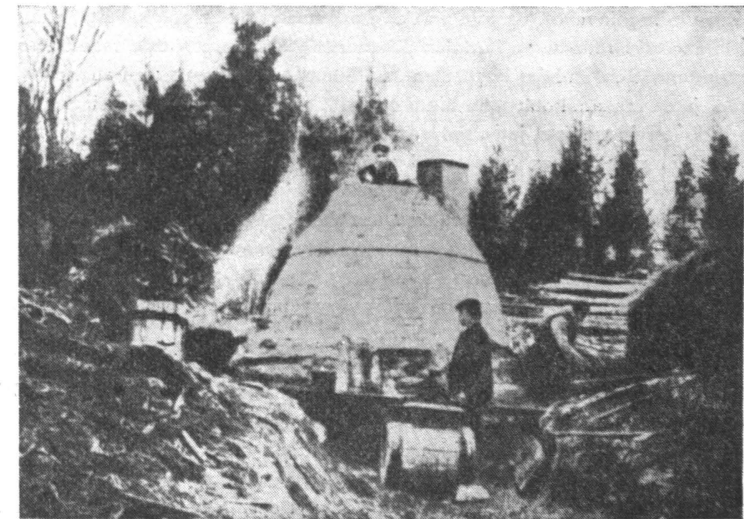
Kuva 21. Suomalainen hyttitervatehdas (Tschirch ja Stock 1933).
