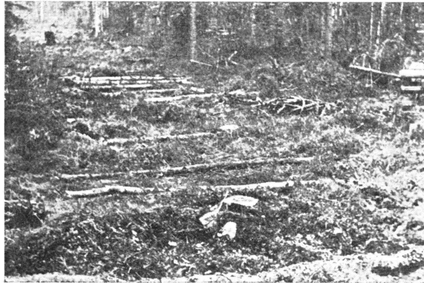
Kuva 6. Valmiiksi raivattua traktoripalstatieta.
