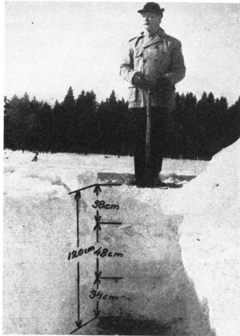
Kuva 26. Puuttomalla suolla oleva polanneajorata keväällä. Tiealueen ulkopuolella oleva maapohja vailla routaa. — Jos tie olisi vastaavissa olosuhteissa pidetty au-raamalla liikennöitävässä kunnossa, se olisi ollut mahdollista vain erittäin suurin kustannuksin.
