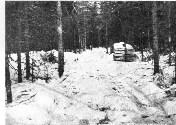
Kuva 13. Traktoripalstatie Kornin työmaalla. Fig. 13. Tractor strip road at the Kornin work site.
