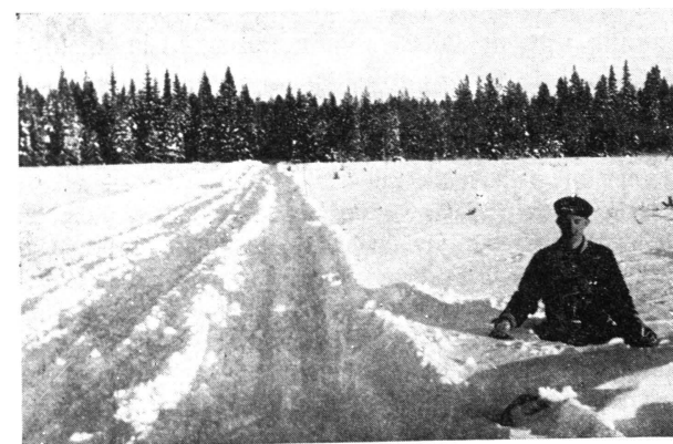
Kuva 11. Aukealla oleva tienosa levitetynä Kornissa ennen lanausta. Lumen syvyys yli 100 cm. Fig. 11. The road section in the open, widened prior to drag-grading. Snow depth over 100 cm.
