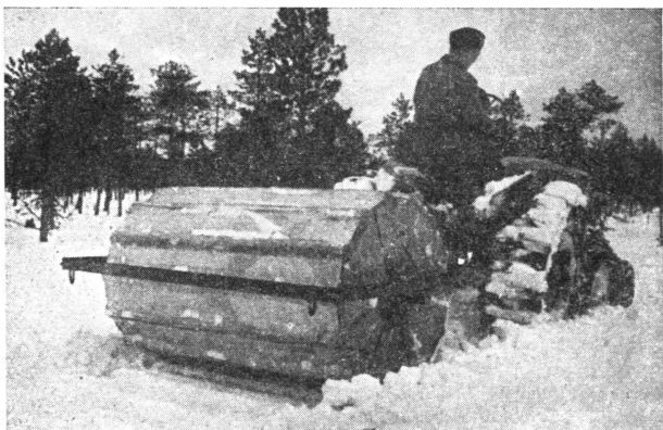
Kuva 8. Tien keskikohdan tiivistäminen jyräämällä. Fig. 8. Roller-packing the road centre.
