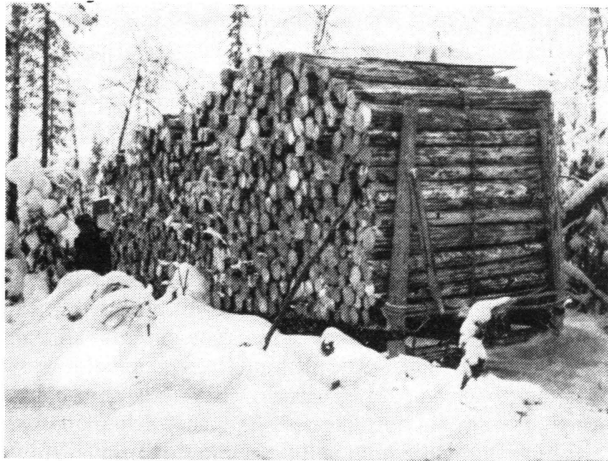
Kuva 15. Valmis, n. 28 p-m 3 suuruinen pinotavarakuorma lähdössä palstatieltä kohti varsitietä ja purkamisvarastoa. Fig. 15. A completed cordwood load of some 28 piled cu.m. ready to start from the strip road for the main haulage road and unloading storage.
